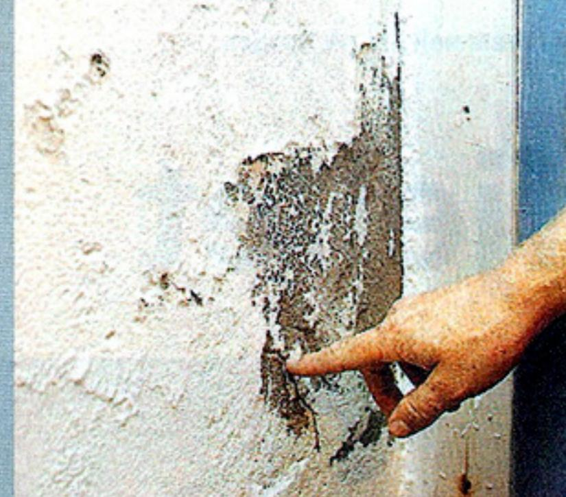
Eksempel på fuktgjennomslag på innvendig mur.
